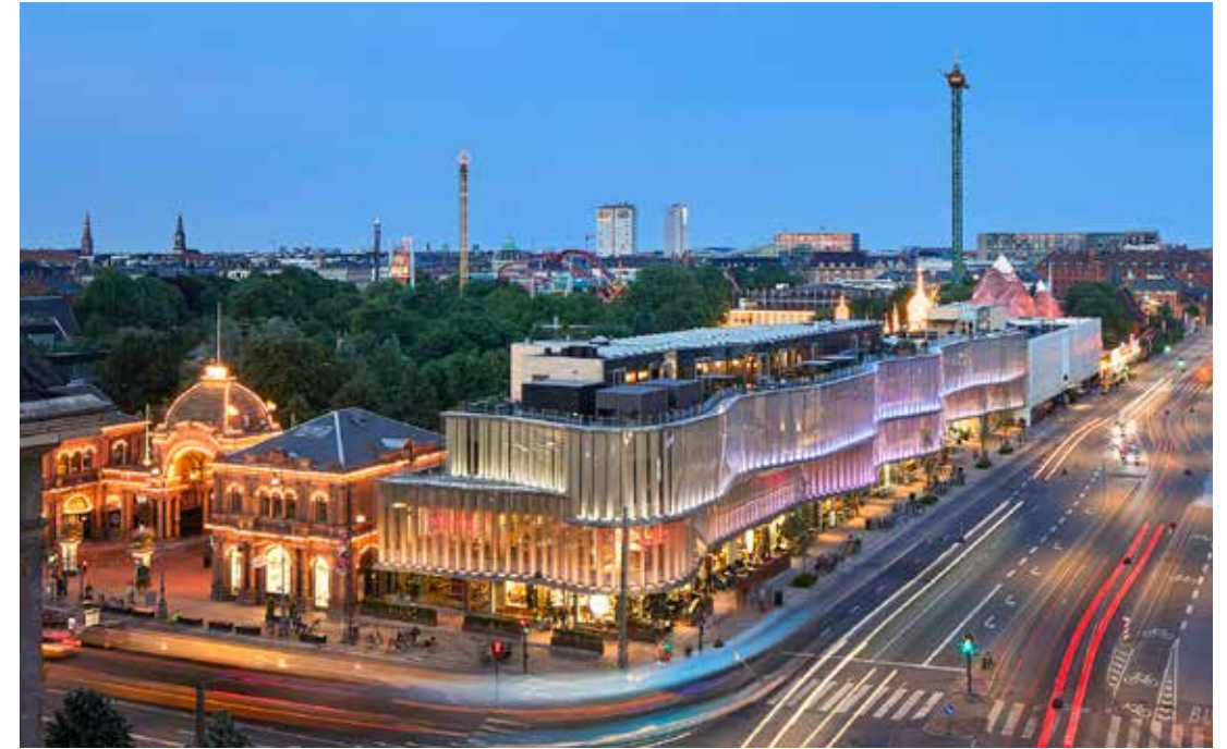
Tivoli Hjørnet Copenhagen, Denmark
